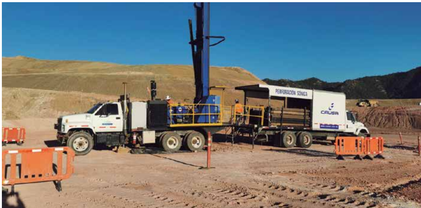
Vista general del equipo de perforación sónica en campo
