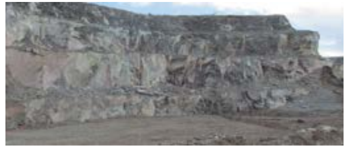
Fotografía 2. Vista de Taludes de la cantera Chapalita en la que se aprecian los planos de las caras de los bancos casi verticales. Nótese también la posición de la pala con respecto a una zona de riesgo.
