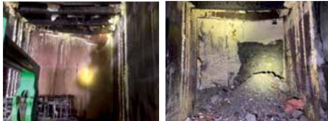
Figura 3,4: Segunda inyección de espuma.
