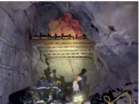
Figura 2: Excavación e instalación de marcos debajo del techo de espuma
