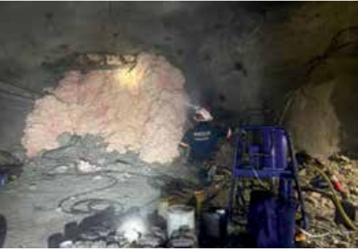
Figura 1. Primer llenado de cavidad desde el suelo encima de rocas caídas.
