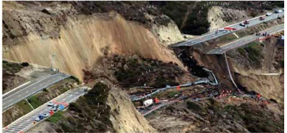
Figura 4. Deslizamiento de terreno en carretera escénica Tijuana-Ensenada ocurrido en diciembre del 2013, atribuido a falta de estudios geológico-estructurales y geomecánicos (foto <http://www.4vientos.net/> ).
