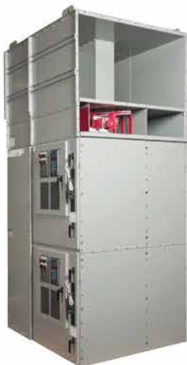
Ampgard AR ha sido ampliamente probado y verificado para cumplir con los requisitos de IEEE C37.20.7-2007 para accesibilidad Tipo 2B (definido como "diseños resistentes a arcos o características en el exterior de libre acceso [frontal, posterior y laterales] del equipo" con la puerta de control de baja tensión abierta).
