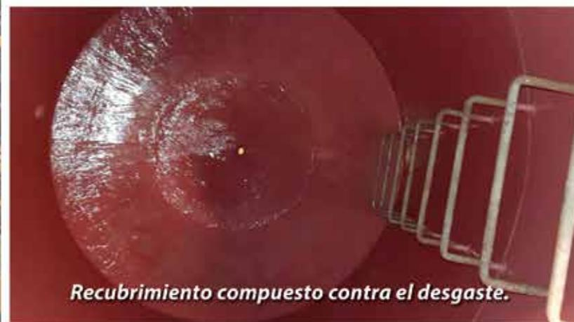
*Recubrimiento compuesto contra el desgaste.*
