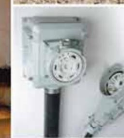
Tomacorrientes y Clavijas para Conexiones de Uso Rudo en Equipo Minero
