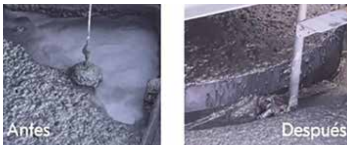
Figura 10. Fotografías del antes y después de la modernización de la zona de espuma en la última celda TC-300 de Constancia.
