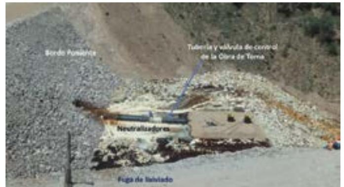
Figura 11. Zona del talud exterior del Bordo Poniente. Se observan las características de la fuga y la aplicación emergente de neutralizadores desde el sitio de la fuga.
