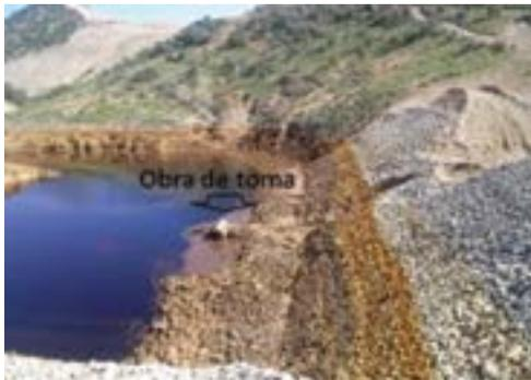
Figura 9. Vista del embalse del Bordo Poniente. Se aprecia en sus taludes el descenso del volumen fugado. Al centro del talud que presentó la falla estructural, se aprecia la cabeza del tubo involucrado en la falla. A la derecha, vista aérea del embalse al presentarse la fuga, se observa la posición de la pluma y su salida hacia aguas abajo.
